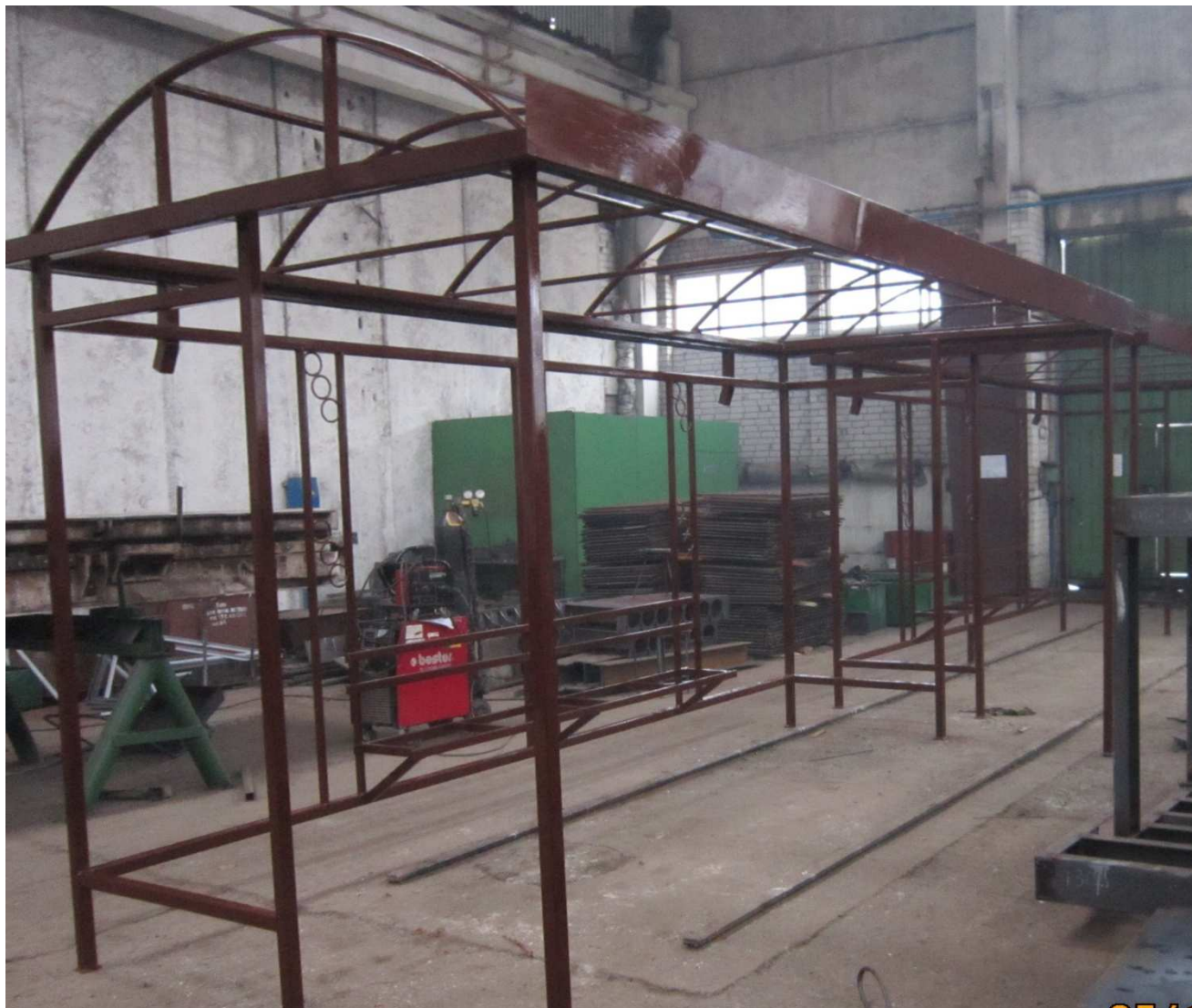
Каркас автобусной остановки.
